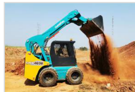
Строительные работы в Иране
