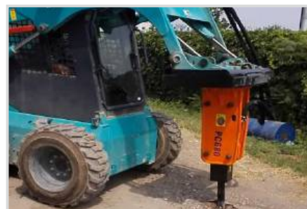
Строительные работы в Бельгии
